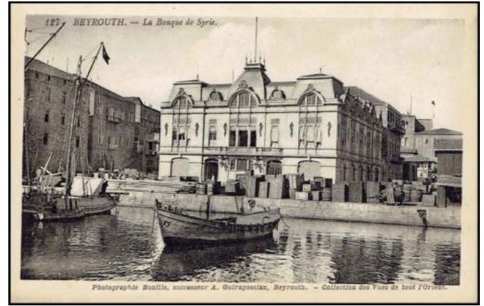
مبنى الفرع الرئيسي للبنك السوري في بيروت
